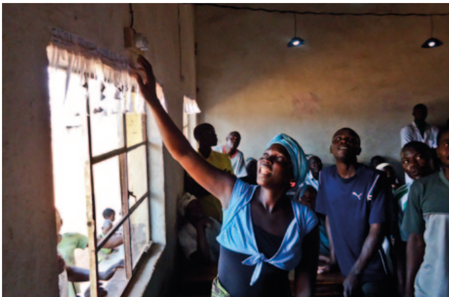
Lichtschaltertest Macaringue. Foto: Ingenieure ohne Grenzen
