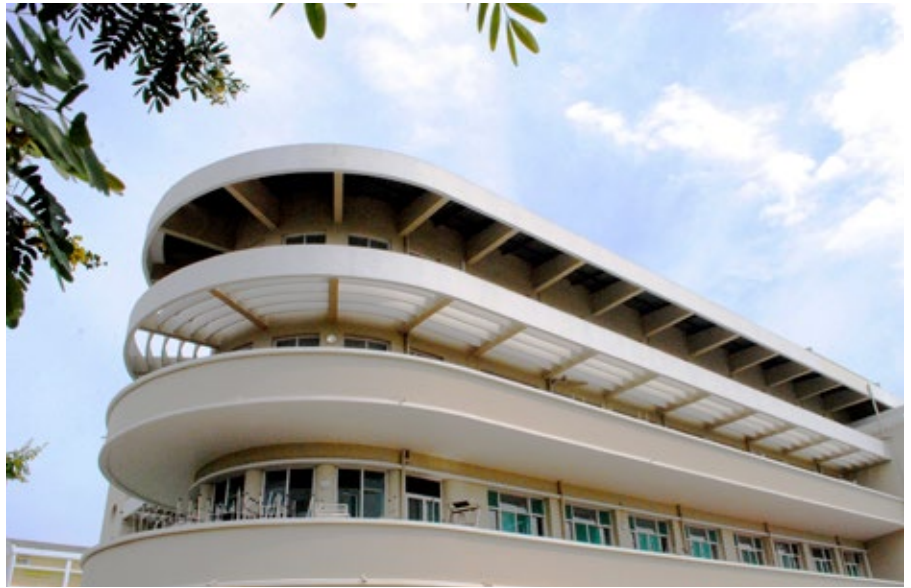
Hospital Central, Isolationsspavillon für Weiße, 1940 von António Rosas im Art déco Stil
