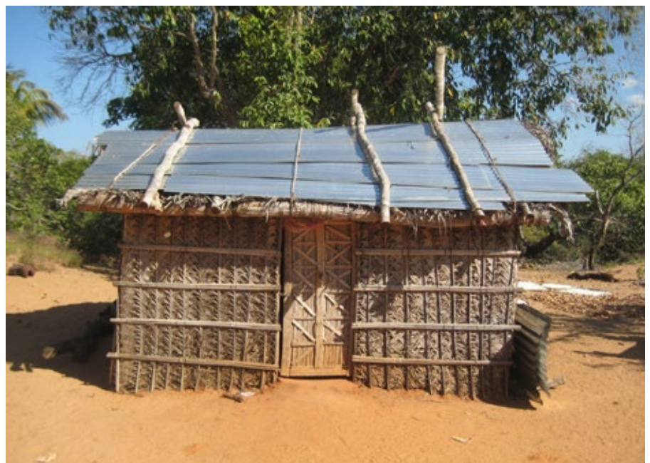
Einfaches Haus mit ergänzender Wellblechdeckung, Distrikt Massinga
